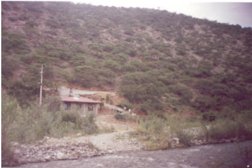
Fig. 5 y 6 Canal de descarga y casa de máquinas en Las Juntas Perú
