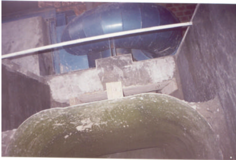
Fig. 3 Tubo de succión acoplado a la carcasa de turbina axial
