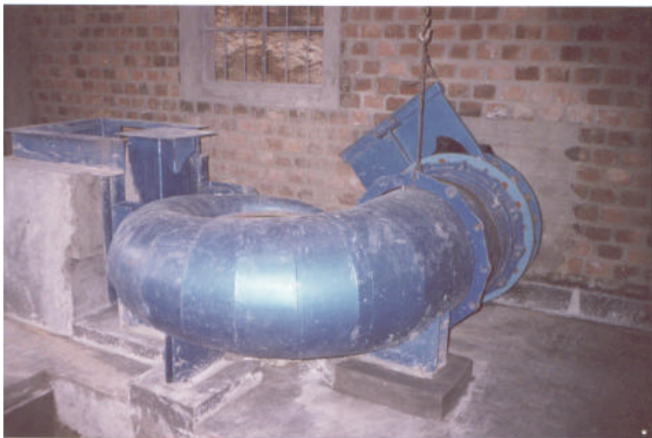
Fig. 1 y 2 Nivelación y cimentación de carcasa de turbina axial
