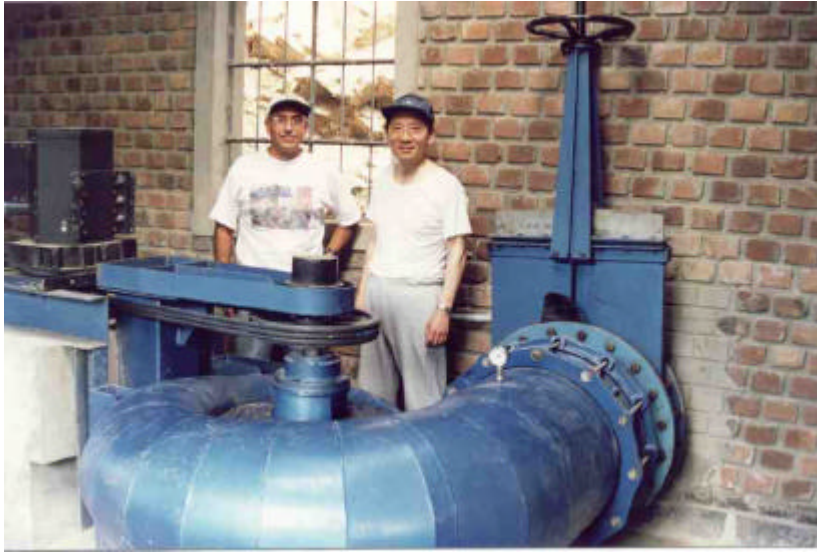
Fig. 7 Turbina axial al finalizar el montaje
