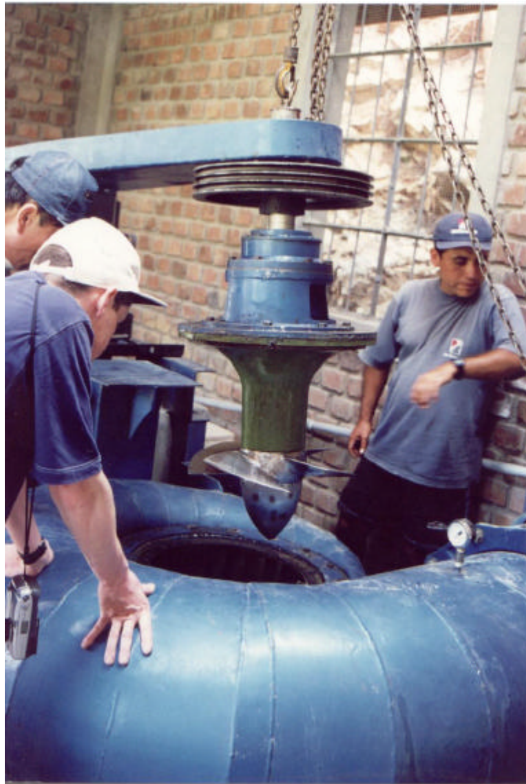
Fig. 6 Acople de eje y componentes a carcasa
